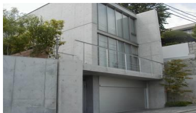
住宅外壁疎水材塗布
