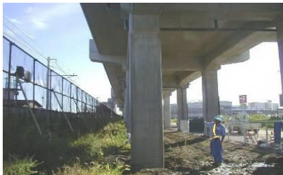
橋脚中性化防止
