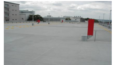
駐車場スラブ面強化(防塵)
