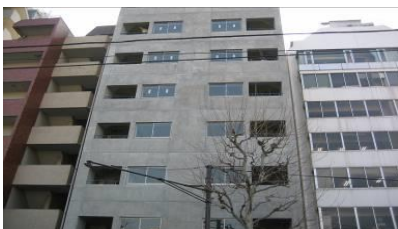
マンション外壁疎水材塗布
